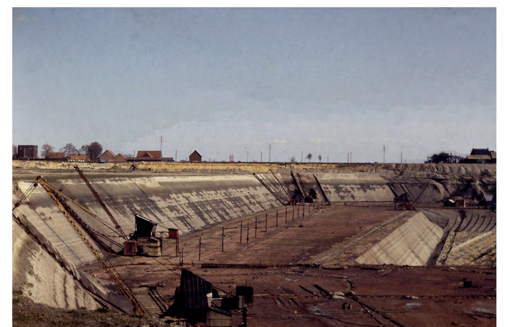
290: Kleigroeve Reet-Rumst, 1972. Schuine wanden en niveaus. Foto FvN.
