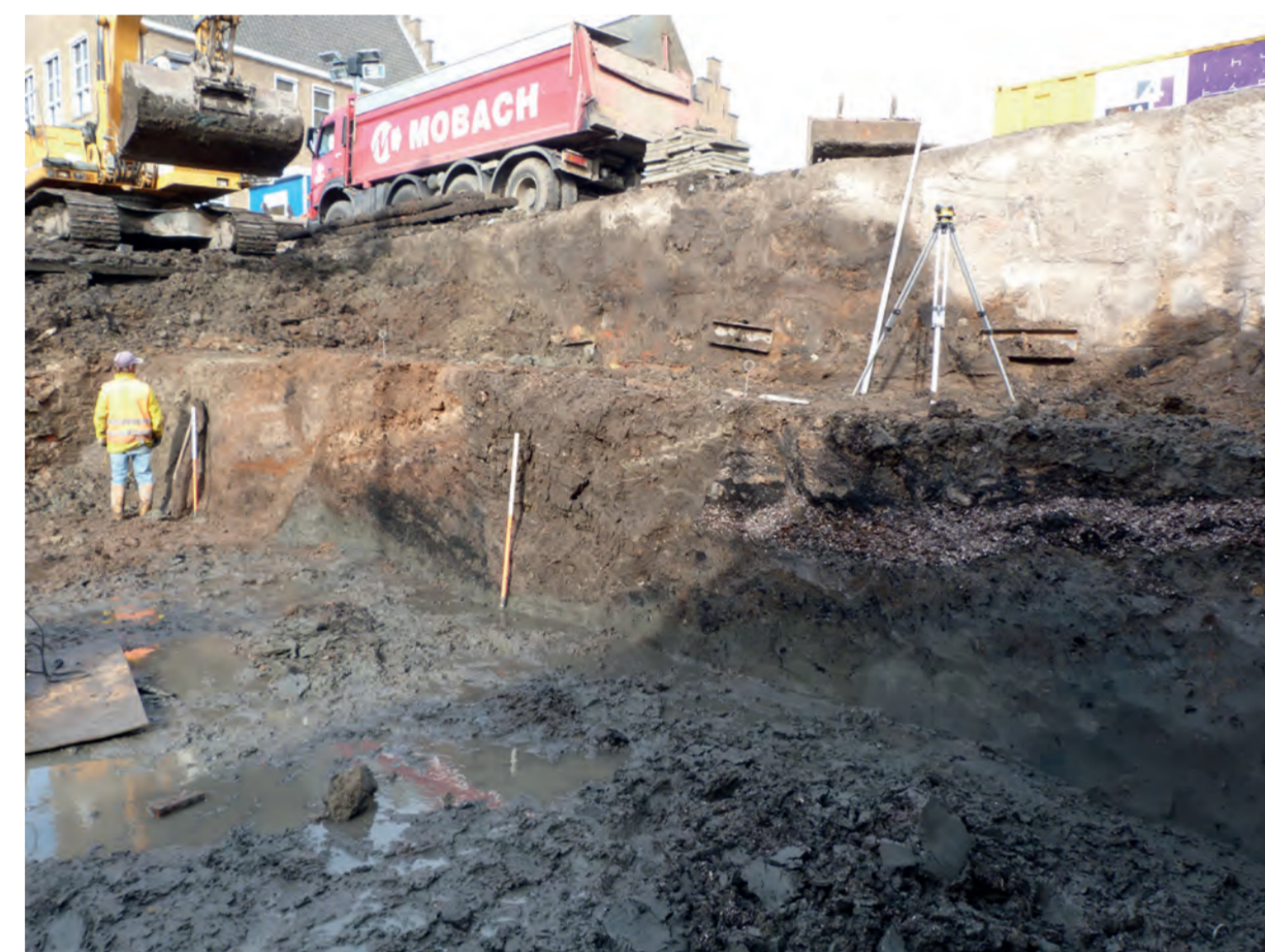
180: Bouwput met restant kademuur Axelse Vaart. (Foto Co van Meurs)
