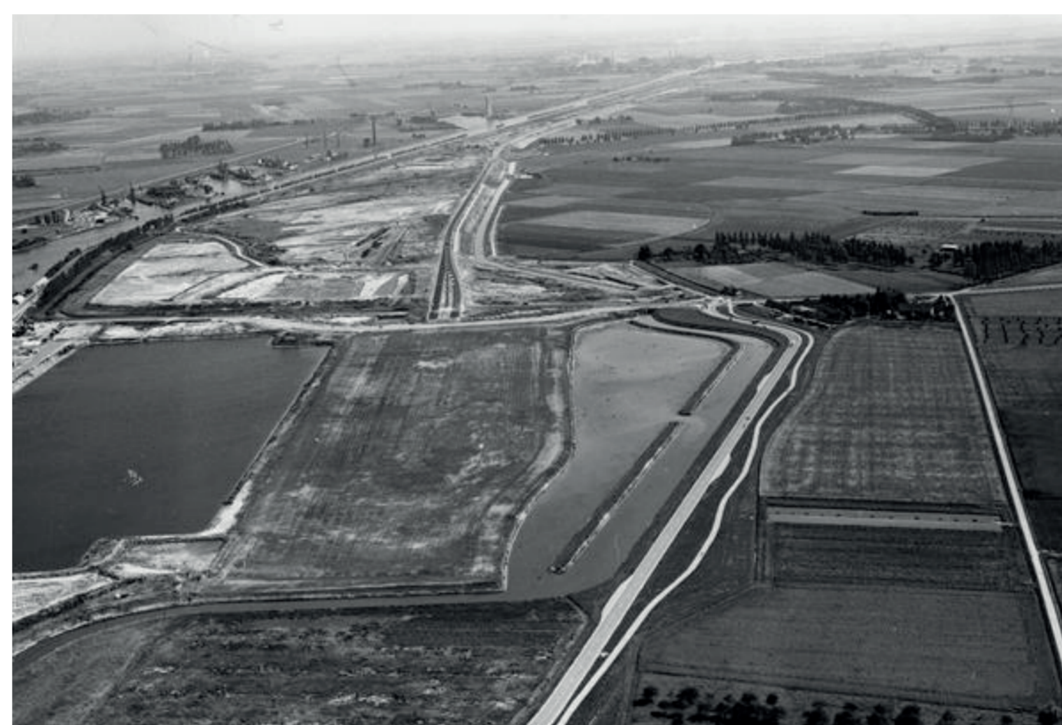
Figuur 15: Bouwput Sluis van Terneuzen 1963. (Foto Beeldbank.rws.nl)
