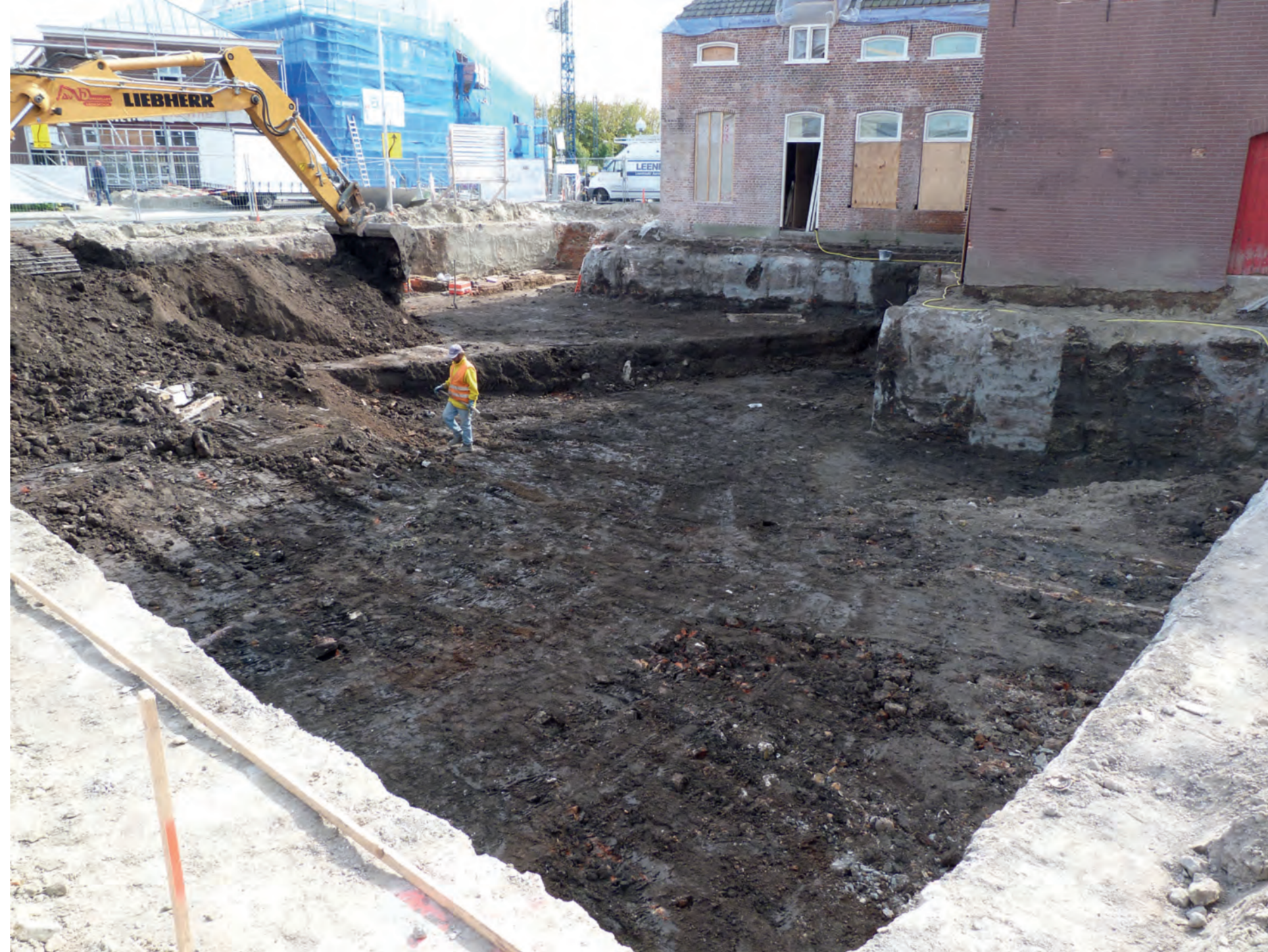
178: Laag voor laag afschrapen van de bovenste dempingslagen in de bouwput. (Foto Artefact)
