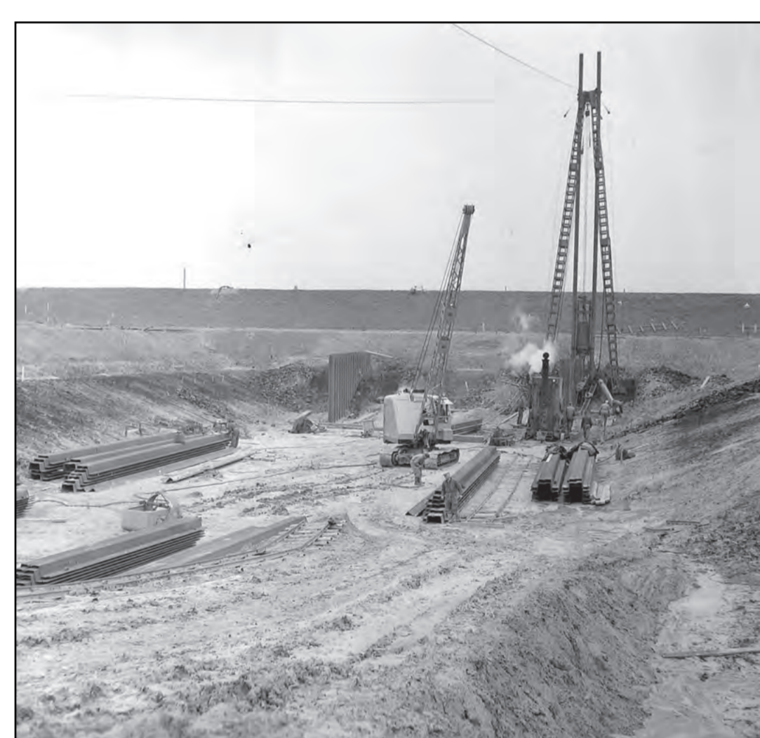
92: Bouwput Sluis Terneuzen 1960 (Beeldbank Zeeland)
