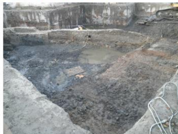
179: Links en rechts de gemetselde kademuren van de Axelse Vaart. (Foto Artefact)
