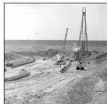
92: Bouwput Sluis Terneuzen 1960 (Beeldbank Zeeland)
