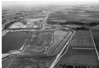
Figuur 15: Bouwput Sluis van Terneuzen 1963. (Foto Beeldbank.rws.nl)
