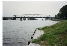
Figuur 16: Brug bij Sluiskil (Foto Beeldbank.rws.nl)
