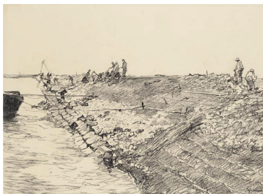
Afb. 10. Dijkbekleding met onderlaag van kramwerk van riet/stro, daarop een laag puin, afgedekt met steenblokken. Tekening: J.H. van Mastenbroek 1931 (Zuiderzeemuseum).
