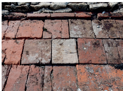
Afb. 11. Gebakken steen als dijkbekleding in de Val bij Zierikzee. Foto: B. Chamuleau 2015.
